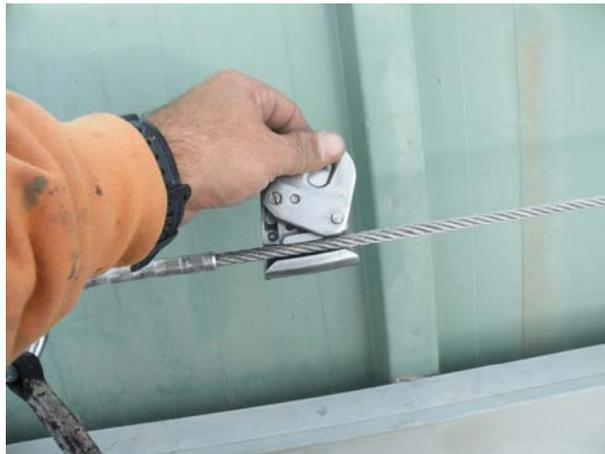
Ahora procederá a colocar el **carro deslizante XS Slider** en la línea de vida horizontal, y posteriormente se anclará al mismo con el extremo libre del subsistema de conexión tipo “**elemento de amarre de doble gancho con absorbedor**” (EN355), mediante un **conector intermedio tipo ovalado EN362**.
