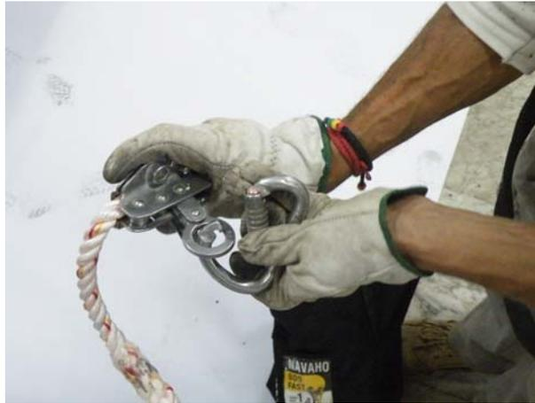
Sólo en ese momento podrá desconectarse del dispositivo anticaídas de la escalera, y comenzar a transitar por la cubierta. Podrá distanciarse tanto como le permita la cuerda (45 m. aprox.) hasta el siguiente punto de anclaje, recordando ajustar siempre la distancia libre de la cuerda mediante el accionamiento del anticaídas deslizante.
