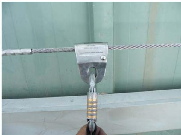
Para la conexión del carro **XS Slider** a la línea de vida, se deberán observar los siguientes pasos:
