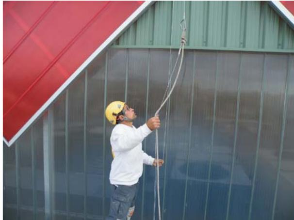
Colocar la **cuerda auxiliar** (15 m. aprox.) utilizando los cordinos-guía para, tirando de ellos, pasar dicha cuerda auxiliar por la barra de anclaje de la escalera.
